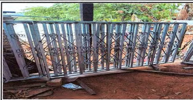
MODULO I: Se observa en la imagen las estructuras metalicas de los balcones a instalar.
