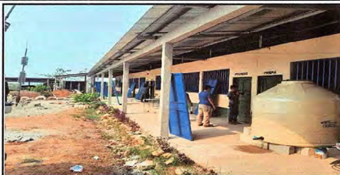
MODULO I. se observa que las puertas son de metal de buena calidad para cada una de las aulas.
