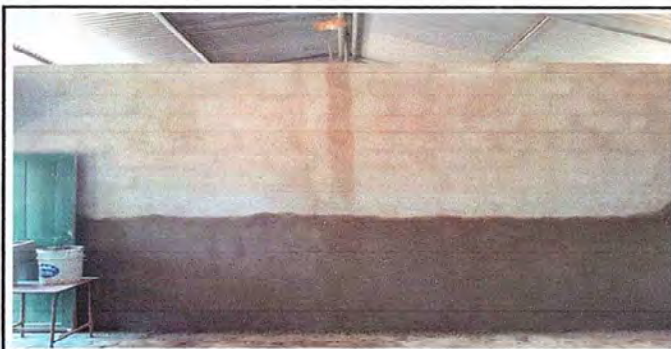
MODULO III. Se observa el avance del repello de toda las intalaciones del edificio escolar.
