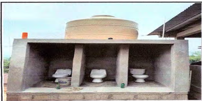
MODULO IV. Se observa en la imagen el avance inmediata de la construccion de los tres baños lavables.
